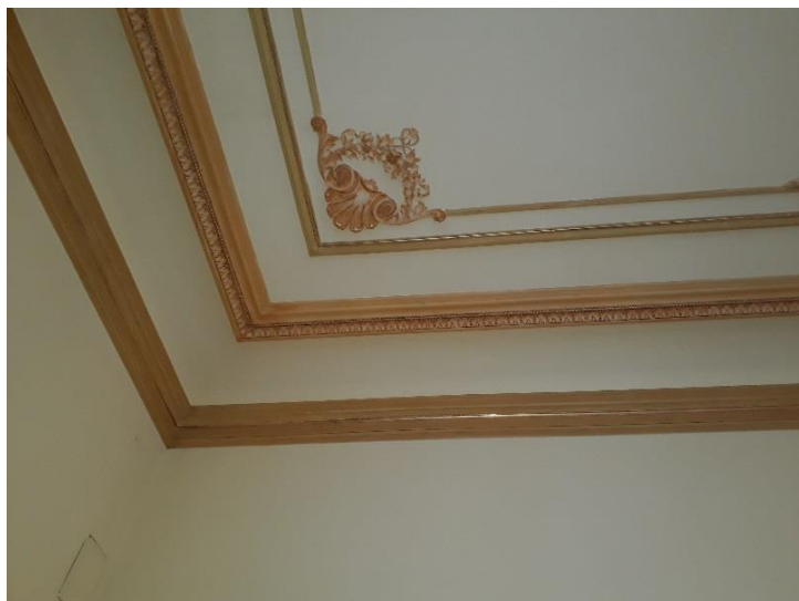
Fotografia 15. Wzór odtworzenia detali na suficie w Pomieszczeniu Prokuratora.
